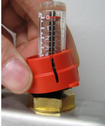
Kuva 9. Virtausmittarin lukitusosan poisto
