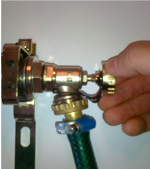
Kuva 6. Venttiin sulkeminen
