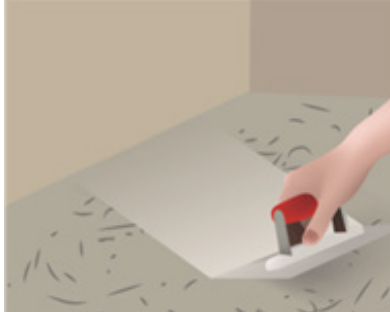
EPÄTASAISUUKSIEN POISTAMINEN- BETONIKIINNITYSPINTA
