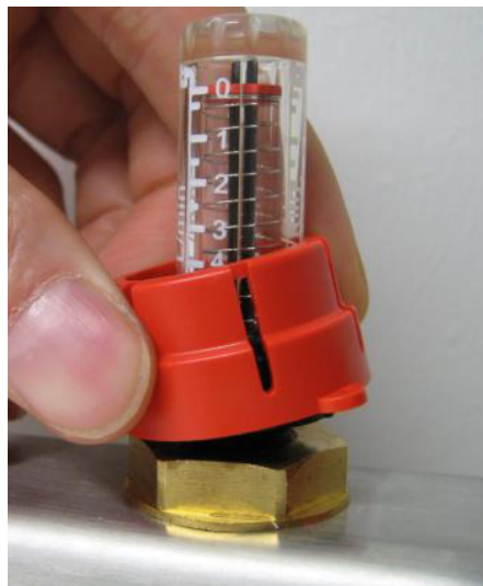
Virtausmittarin lukitusosan poisto
