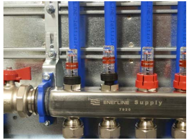
Veden juoksuttaminen yksittäisessä piirissä.
