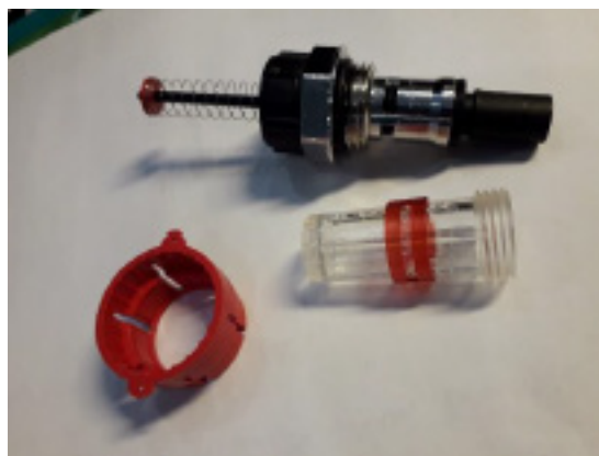
Kuva 3. Irroita virtausmittarin läpinäkyvä kupu kiertämällä sitä vastapäivään. Tarkasta virtausmittarin toiminta painamalla virtausmittarin näyttintä alaspäin jakotukin suuntaan. Jos virtausmittarin näyttin ei liiku jouhevasti on virtausmittari syytä vaihtaa. Roskat ja epäpuhtaudet saattavat tukkia virtausreitit ja näyttintä alaspäin painamalla saadaan mahdollinen lika liikkeelle.
