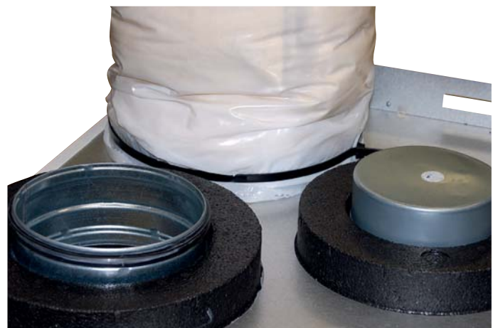
Valmiiksi asennettu kanava.
