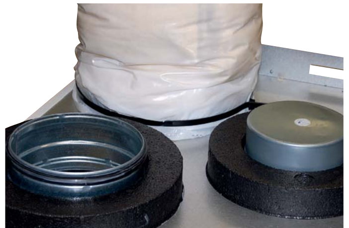
Valmiiksi asennettu kanava.
