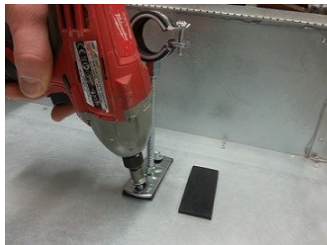
3. kuva Kannakkeiden asennus
