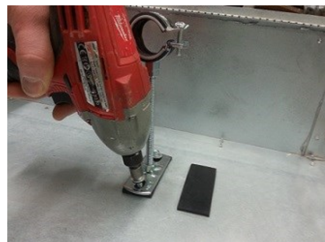
3. kuva Kannakkeiden asennus
