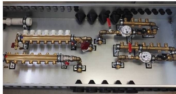
3. kuva Kannakkeiden asennus
