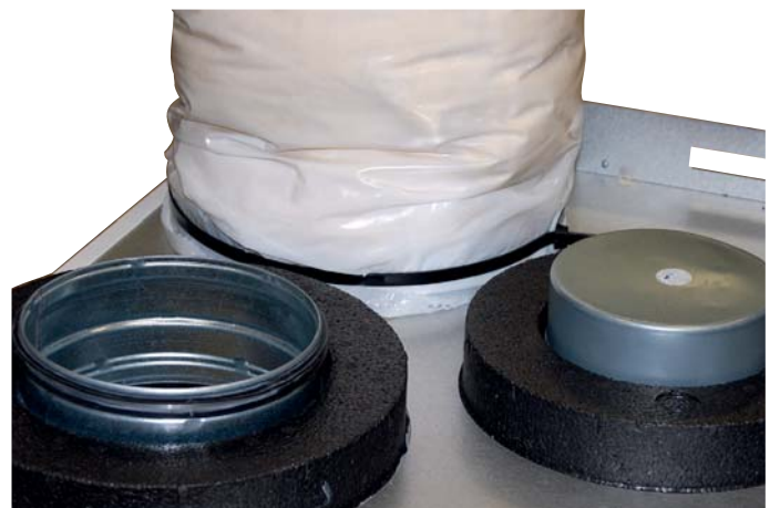
Kuva 20 Valmiiksi asennettu kanava
