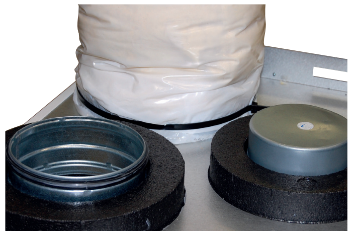
Kuva 21 Valmiiksi asennettu kanava
