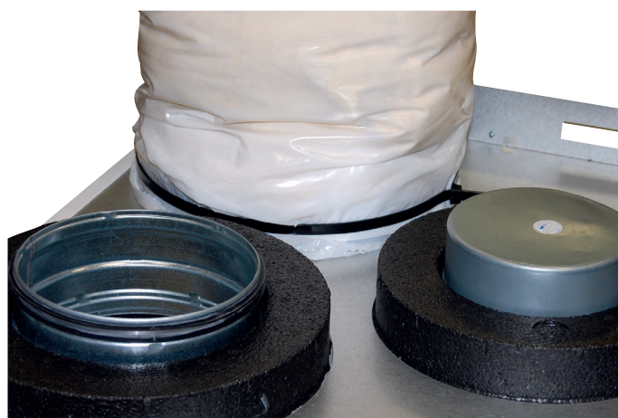
Valmiiksi asennettu kanava.
