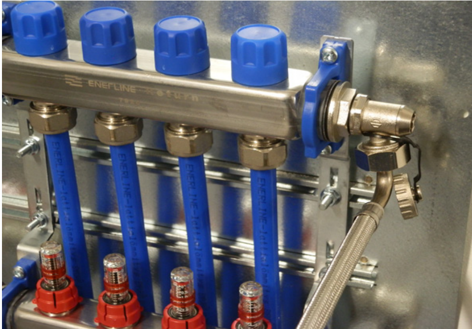
Kuva 2. Ilmausletku kytkettynä ilmauspäätyyn.
