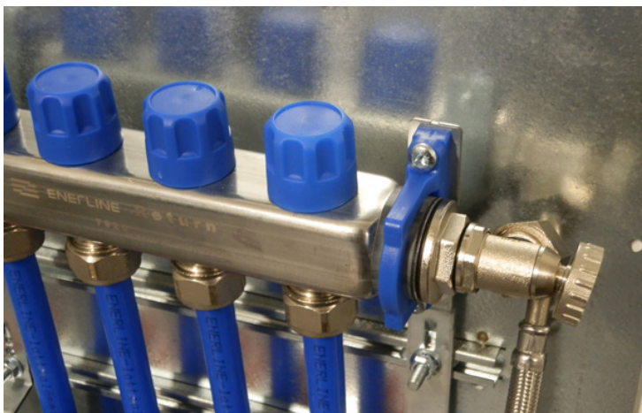
Kuva 3. Ilmauspäädyn venttiilin avaaminen.
