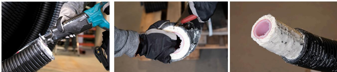
2. Ta bort uretanisolering från röret genom att dra in skalverktyget mot mediaröret och dra det sedan i mediarörets längdriktning på rörets yta. Tvårör-rör: avlägsna uretanisoleringen även mellan mediarören, med hjälp av skalverktyget.
