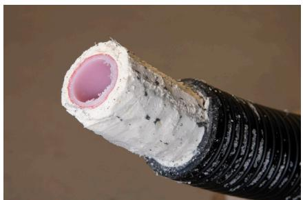
2. Poista putken uretaanieriste tekemällä kuorintalangalla vетоja virtausputken pintaa pitkin. Kaksiputkiset putket: Poista kuorintalangalla uretaani myös virtausputkien välistä. Huom! Varo sahaamasta ja vaurioittamasta virtausputkea.
