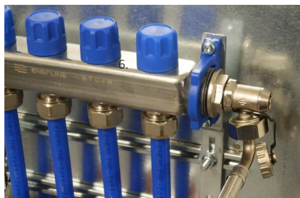
Ilmausletku kytketään ilmauspäättyyn.
