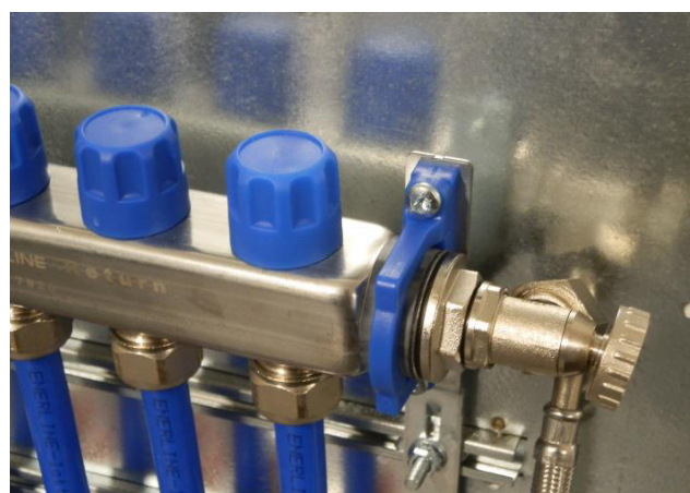
Ilmauspäädyn venttiilin avaaminen.
